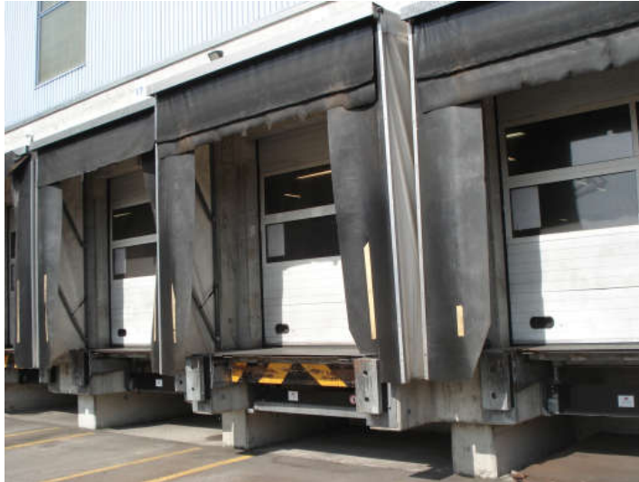
Abbildung 5.3-5 Rampe mit Torrandabdichtung bei einem Vergleichsprojekt
